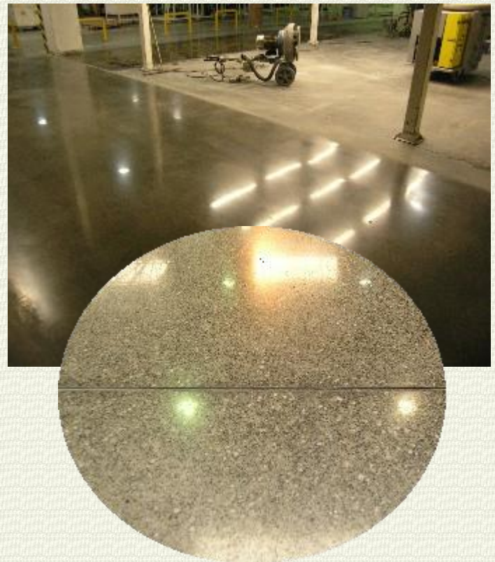
Betónový povrch po leštení
