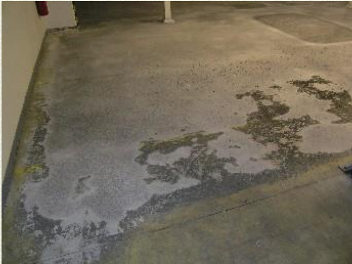
Betónový povrch pred leštením
